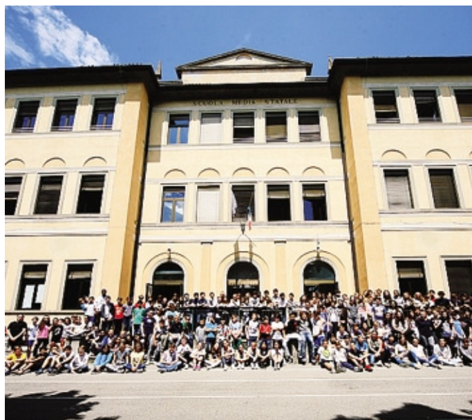
L'edificio sarà probabilmente abbattuto per edificarne uno nuovo
