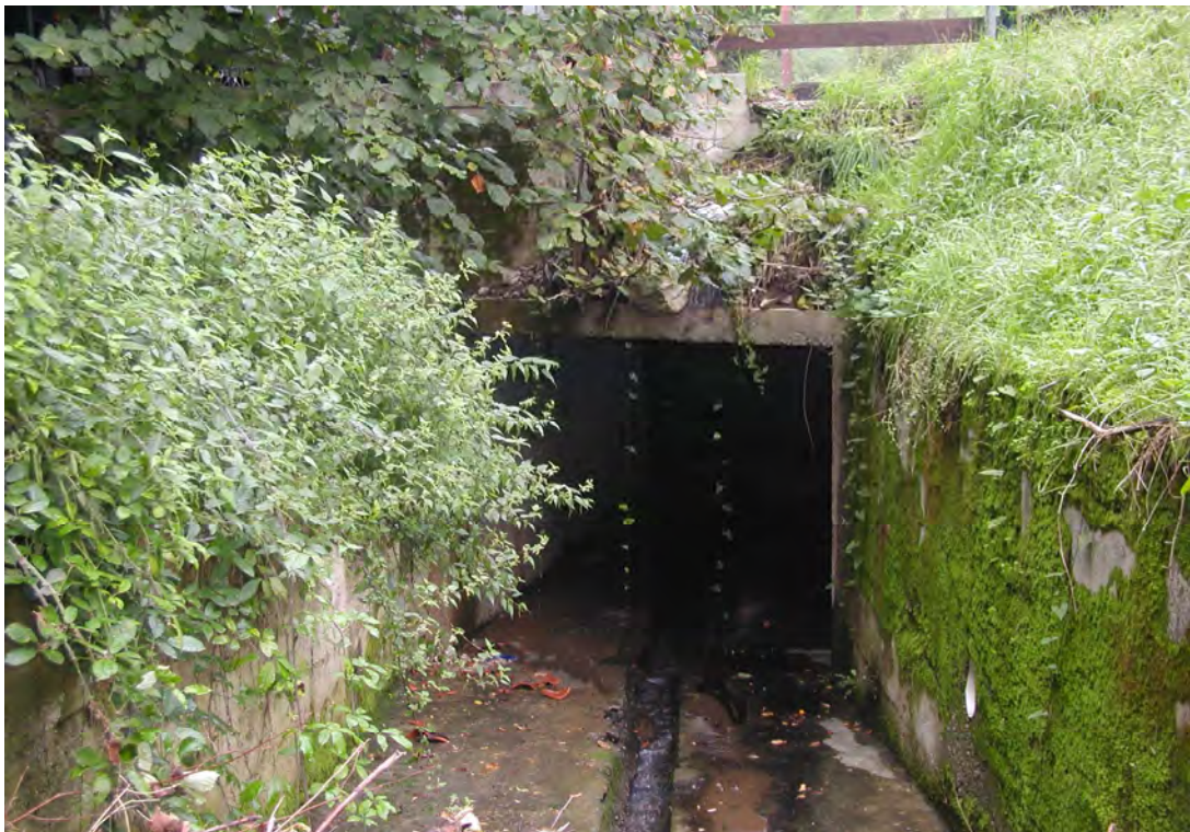
Torrente Gaggio. Tratto intubato in località Gaggio
