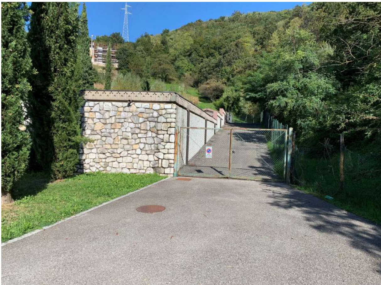
VISTA ACCESSO DI SERVIZIO DA VIA DON GIOVANNI GELFI SUL LATO EST DEL CIMITERO DI BRUNTINO
