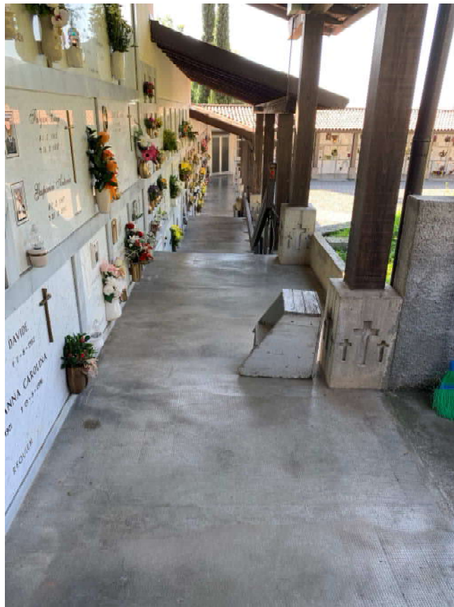
RAMPE SCALE DI COLLEGAMENTO SITUATE NELL'EDIFICIO IN LATO EST
