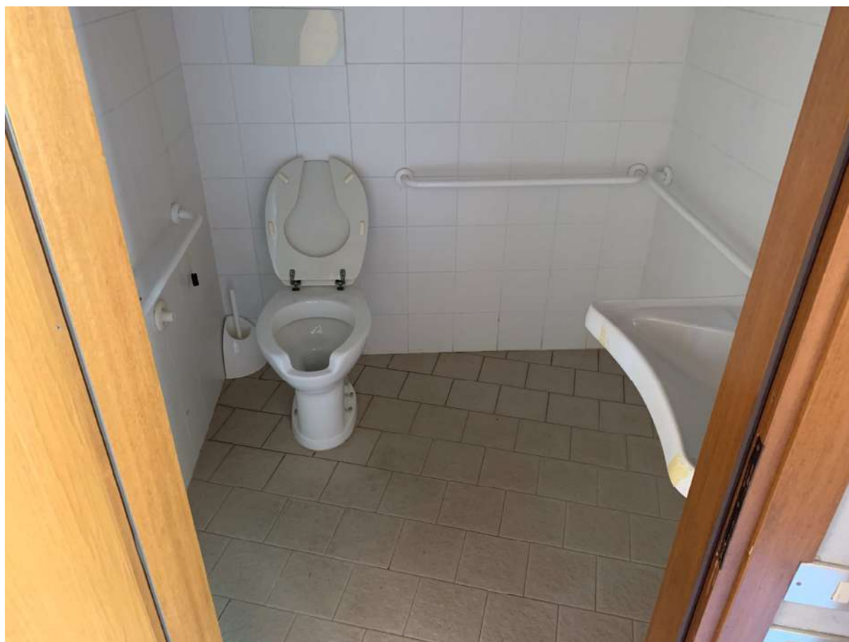
VISTA SERVIZI IGIENICI - BAGNO DISABILI
