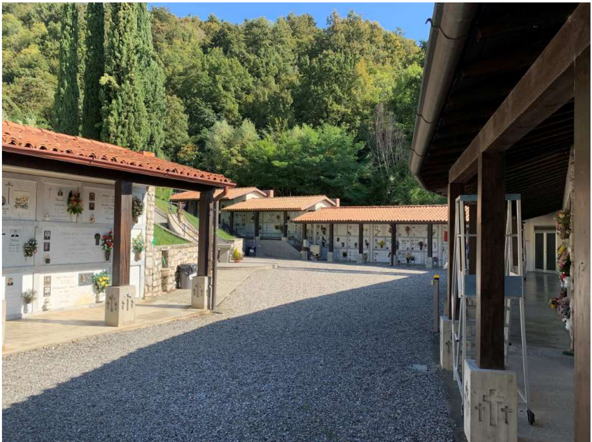
LOCULI E OSSARI NEGLI EDIFICI DELLA PARTE INFERIORE DEL CIMITERO COMUNALE DI BRUNTINO
