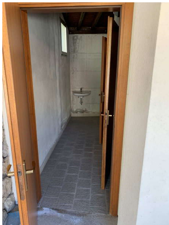
VISTA SERVIZI IGIENICI - LOCALE DISIMPEGNO
