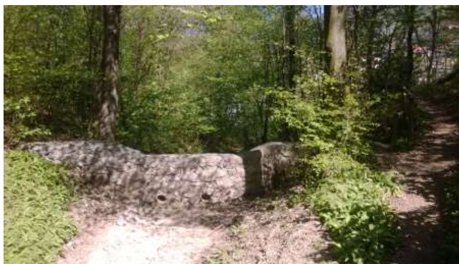
Figura 4. Ripresa fotografica dell’esistente briglia in pietrame per il contenimento del trasporto solido.
