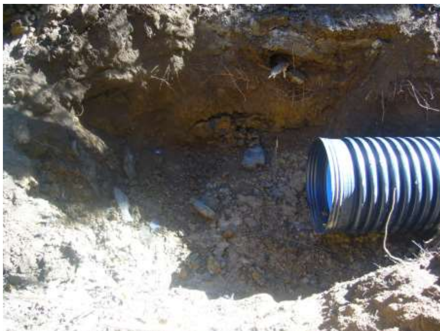
Figura 15. Esempi di applicazioni analoghe: posa tubazione interrata del tipo in polietilene ad alta densità, corrugata esternamente.
