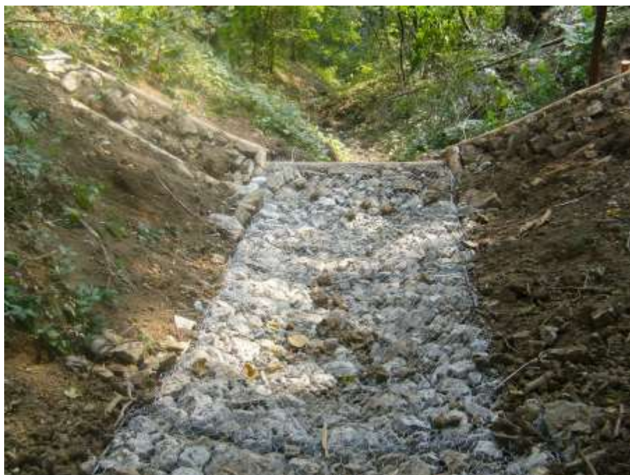
Figura 24. Esempi di applicazioni analoghe: canale in pietra a sezione trapezoidale realizzato con materassi metallici e pietrame.
