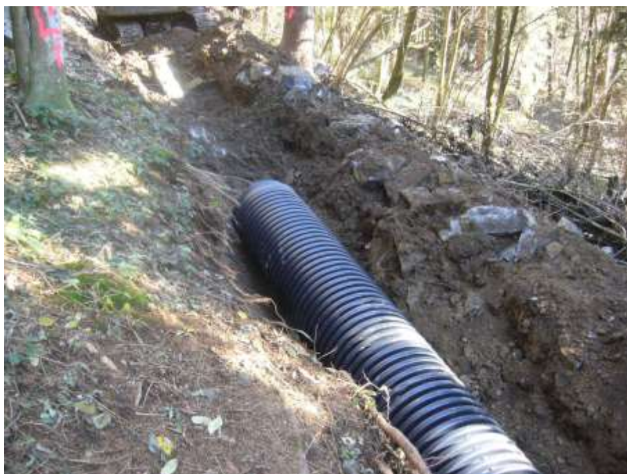
Figura 14. Esempi di applicazioni analoghe: posa tubazione interrata del tipo in polietilene ad alta densità, corrugata esternamente.
