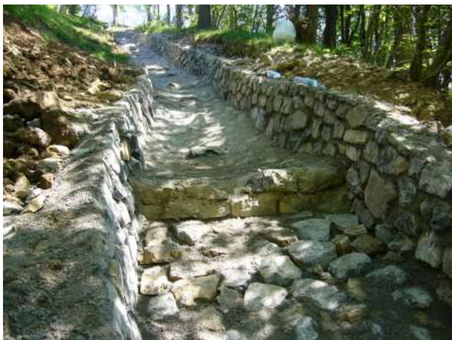
Figura 22. Esempi di applicazioni analoghe: canale in pietra a sezione rettangolare.
