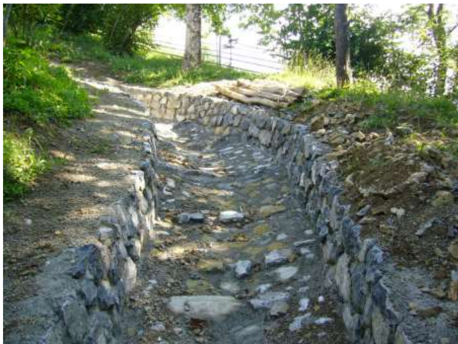
Figura 21. Esempi di applicazioni analoghe: canale in pietra a sezione rettangolare.
