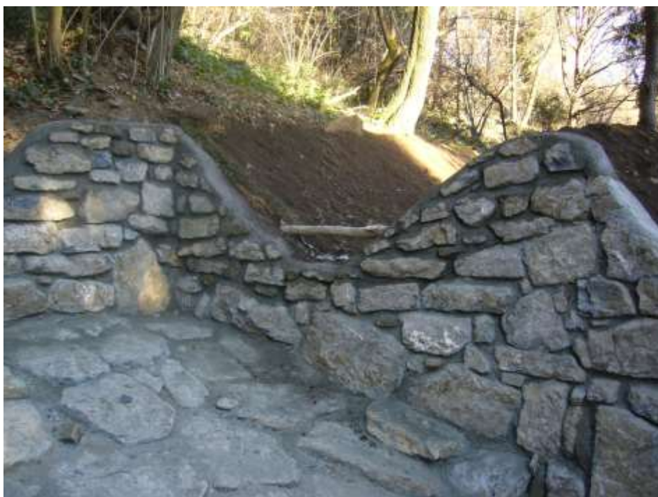
Figura 13. Esempi di applicazioni analoghe: briglia in pietrame e calcestruzzo.
