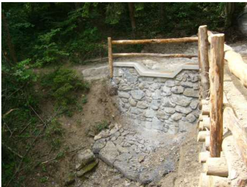
Figura 12. Esempi di applicazioni analoghe: briglia in pietrame e calcestruzzo.
