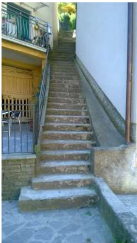
Figura 3. Ripresa fotografica della scaletta attraverso la quale attualmente transitano gran parte delle portate del torrente durante piogge intense
