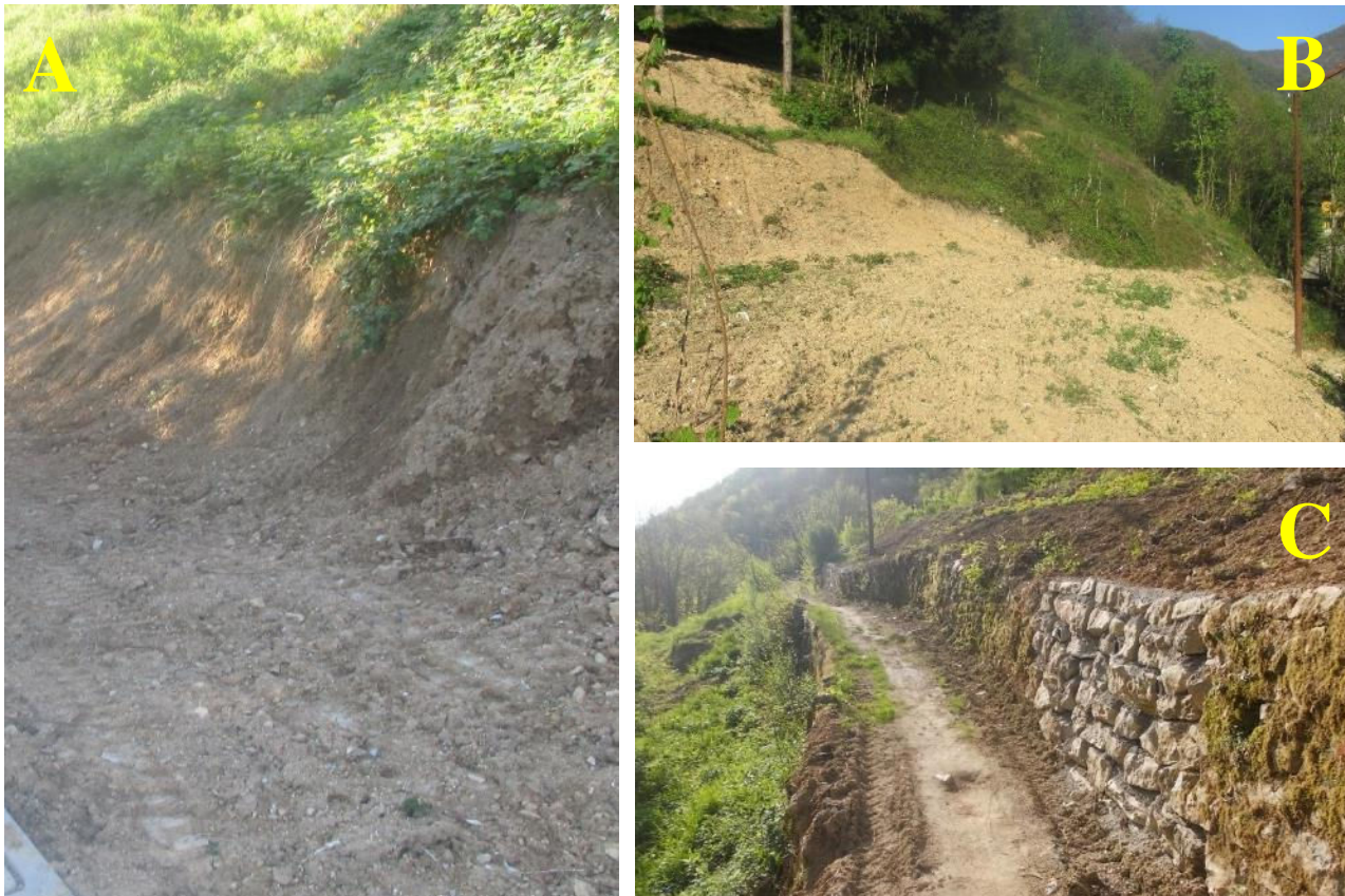
Terreno eluvio-colluviale interessato dagli scavi (A) e riporti sulle balze (B); rifacimento di muretto a secco (C)
