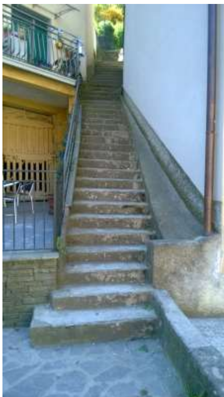
Figura 3. Ripresa fotografica della scaletta attraverso la quale attualmente transitano gran parte delle portate del torrente durante piogge intense
