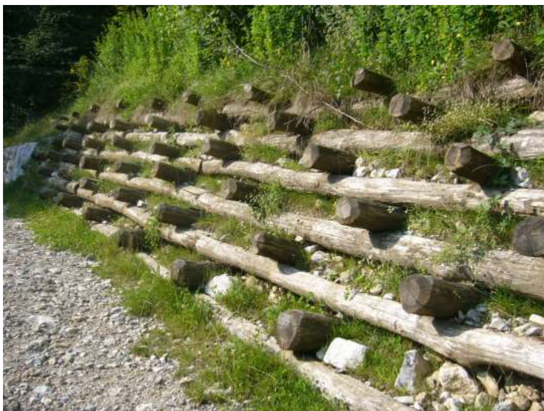
Figura 18. Esempi di applicazioni analoghe: palificata doppia viva con tronchi di castano.
