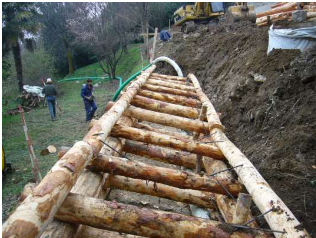
Figura 19. Esempi di applicazioni analoghe: palificata doppia viva con tronchi di larice.
