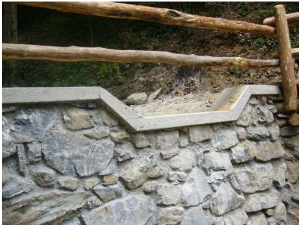
Figura 16. Esempi di applicazioni analoghe: briglia in pietrame con gaveta trapezia in cls.
