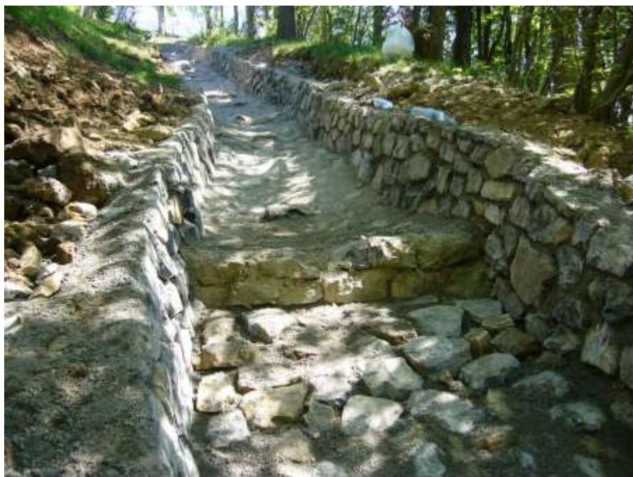
Figura 13. Esempi di applicazioni analoghe: canale in pietra a sezione rettangolare.
