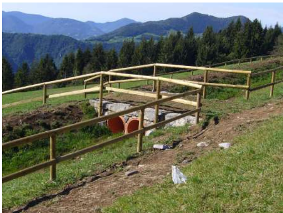
Figura 20. Esempi di applicazioni analoghe: barriera di protezione alveo con attraversamento per animali.
