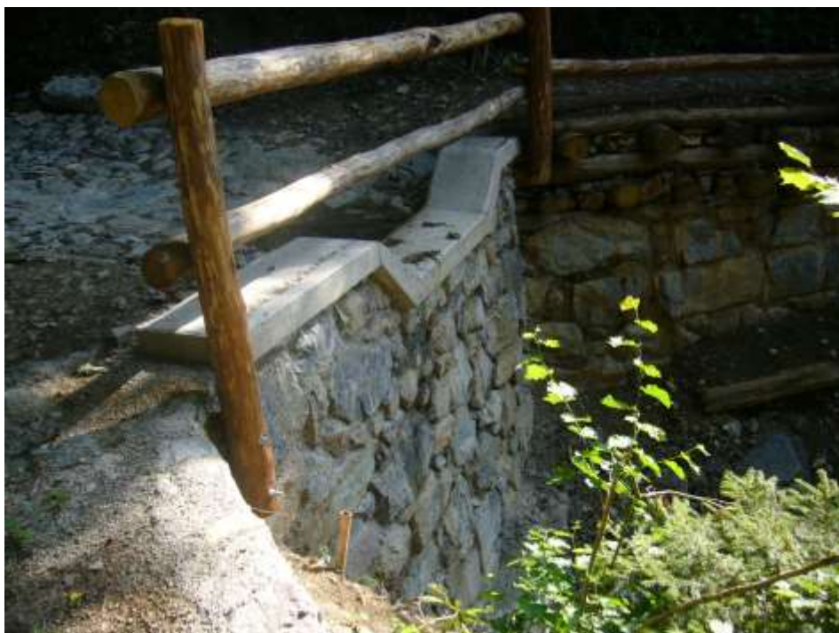
Figura 17. Esempi di applicazioni analoghe: briglia in pietrame con gaveta trapezia in cls.
