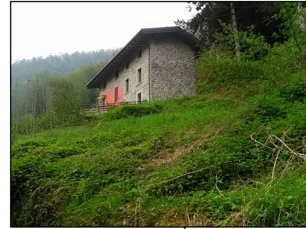
Edificio esistente lato nord - ovest
