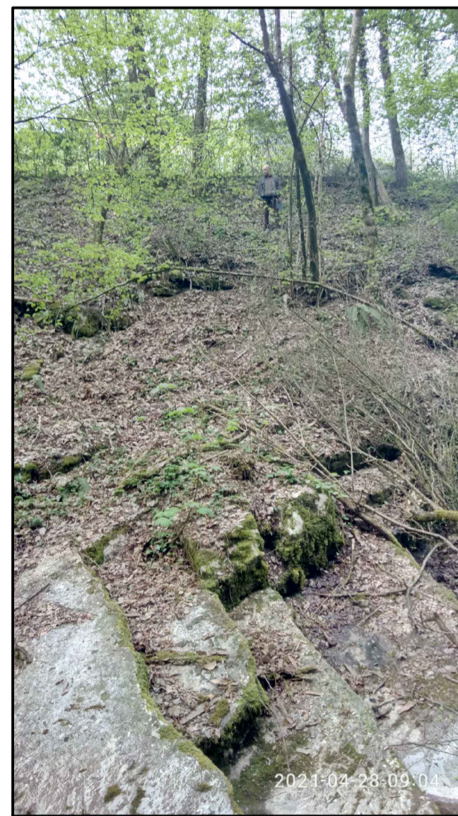
Tratto terminale di raccordo con torrente Giongo in roccia
