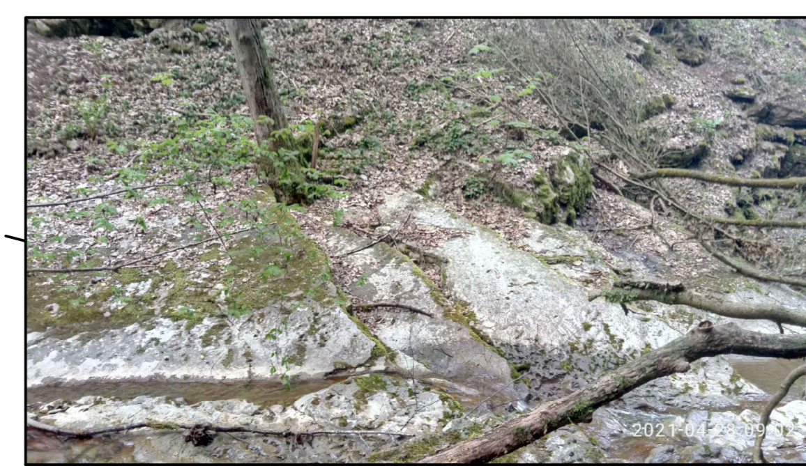
Tratto terminale di raccordo con torrente Giongo in roccia
