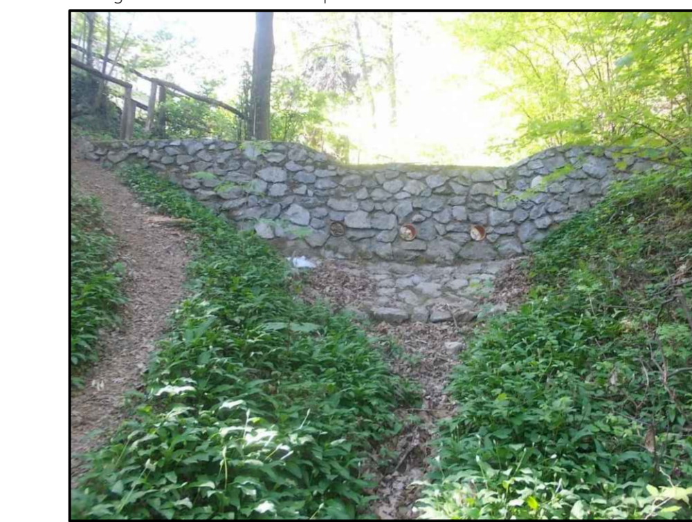
tubo corrugato polietilene D.I. Ø 500 slow motion
