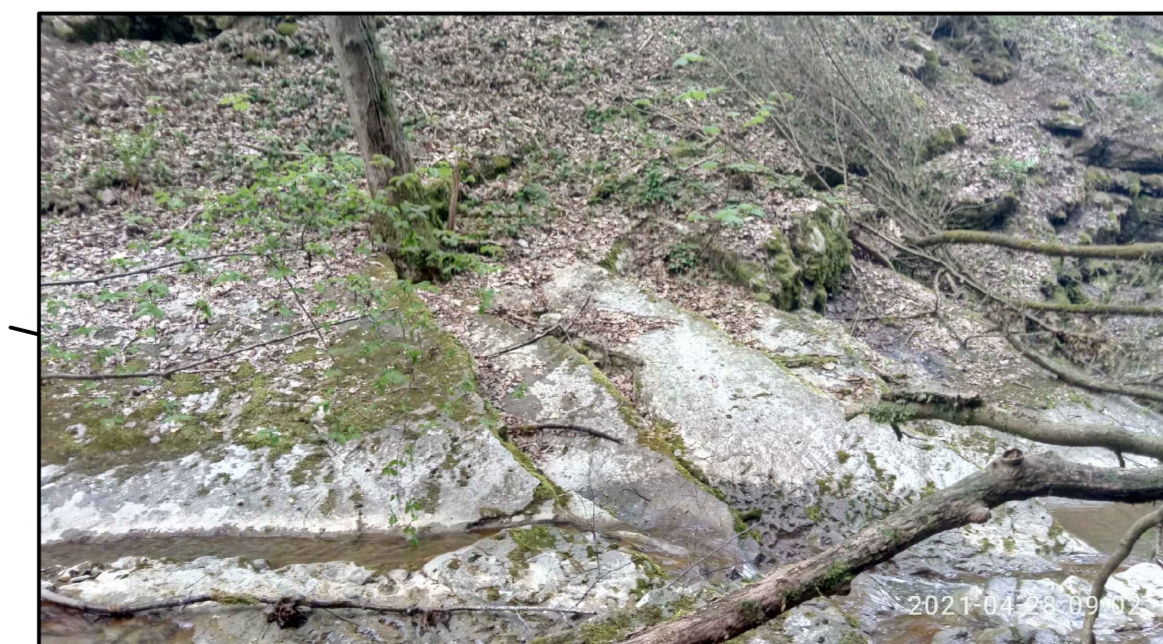
Tratto terminale di raccordo con torrente Giongo in roccia
