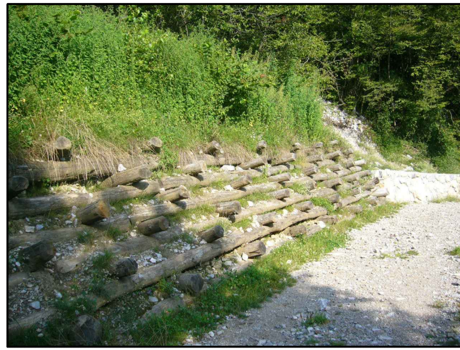
Esempio applicazione palificata doppia viva
