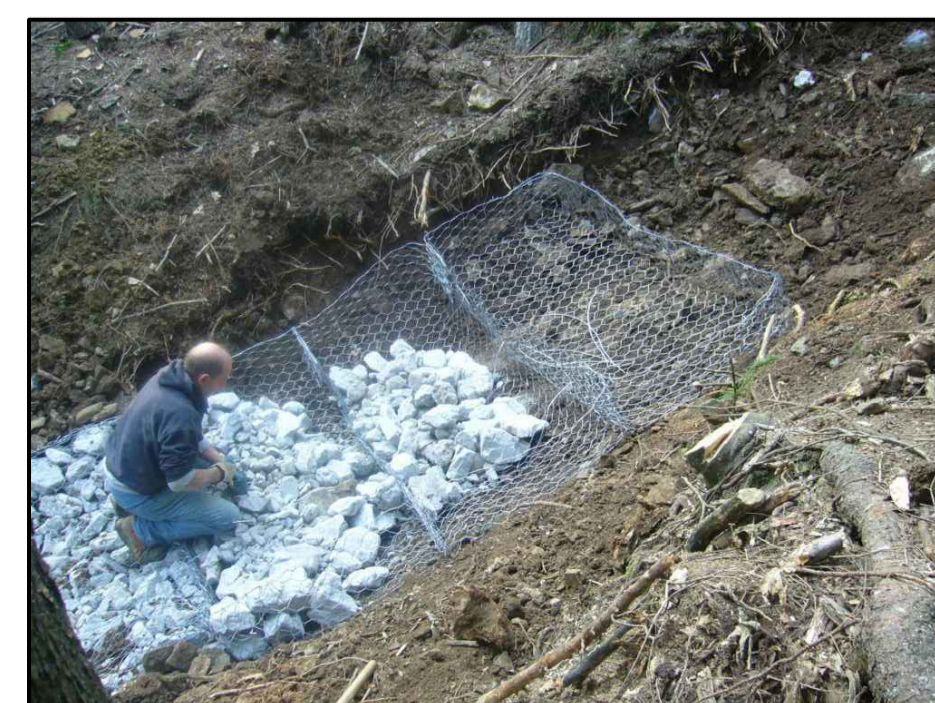
Esempio di riempimento materassi metallici e pietrame
