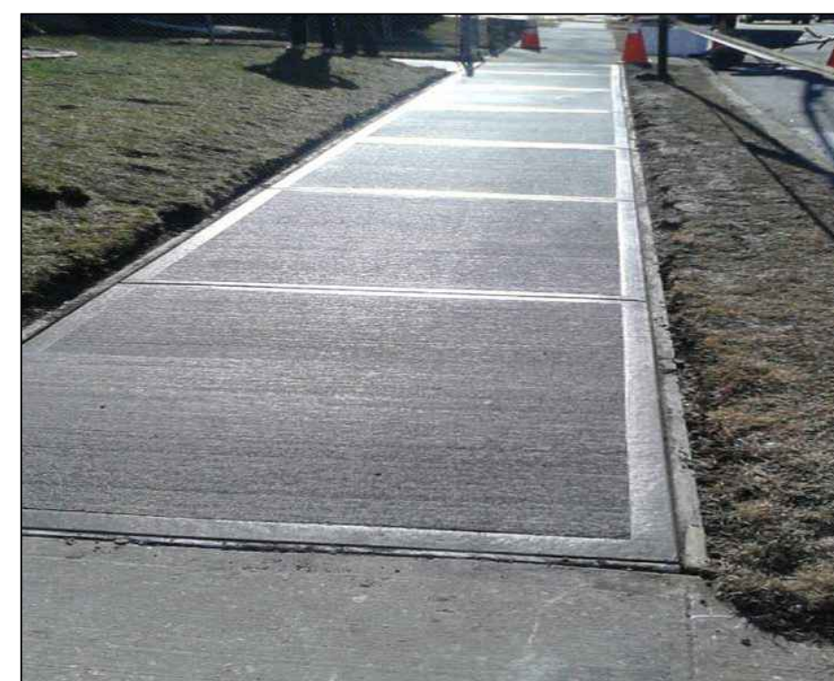
FINITURA PAVIMENTAZIONE IN CALCESTRUZZO PETTINATO
