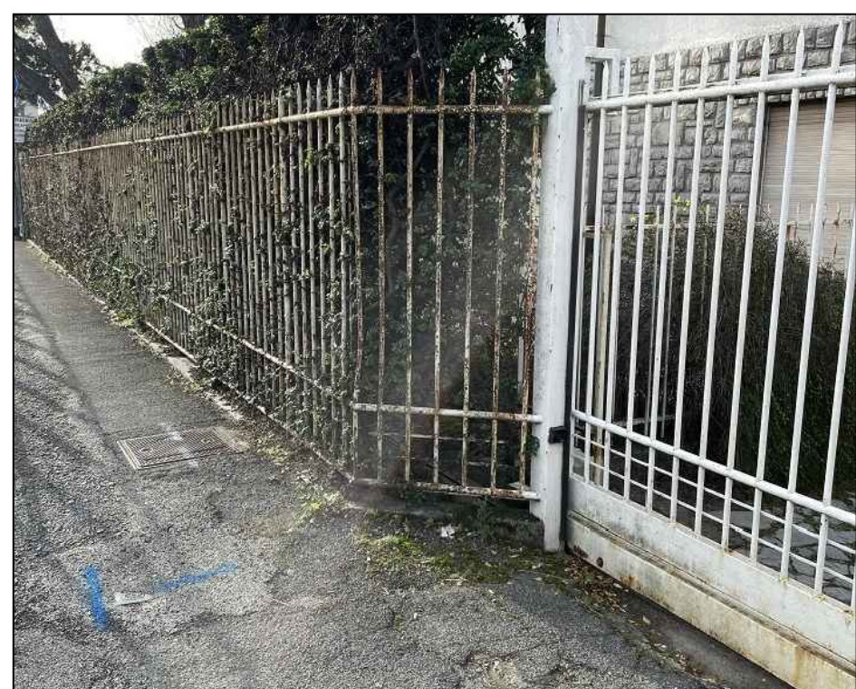
RECINZIONE IN ACCIAIO ZINCATO VERNICIATA A POLVERE
