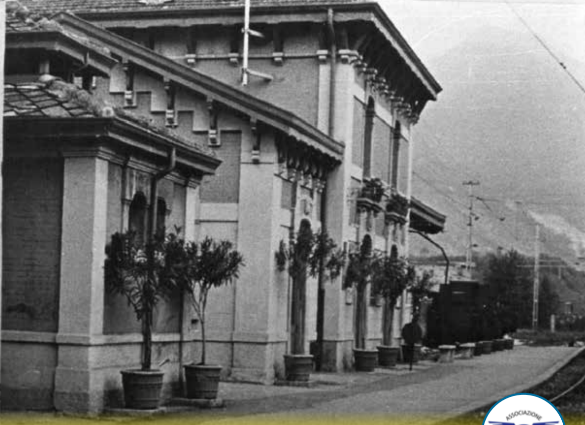
Interno stazione di Villa d'Almè. Foto: dall'archivio dell'Associazione Ferrovia Valle Brembana
